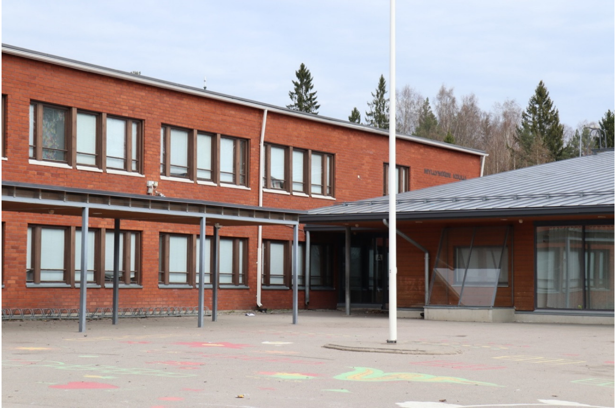
Kuva: Myllymäen koulun päärakennus kuvassa vasemmalla, oikealla laajennusosa. (Lähde: Wikipedia)
