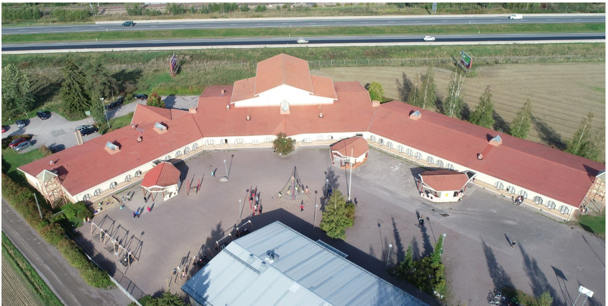
Kuva: Hepolan koulu ilmakuvaattu pihan suunnasta, etualalla "viipalekoulun" katto. Sisäänkäynnin edustan kolme sadekatosta erottuvat välituntipiha reunoilla. Ylin rakennusosa käsittää IV-konehuoneen.
