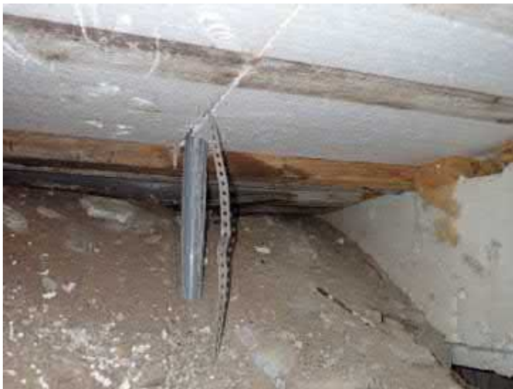
Kuva 8. Kastunutta puumateriaalia.
