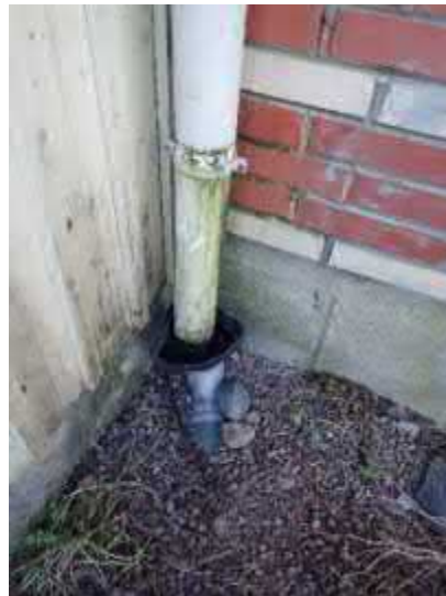
Kuvat 9, 10 ja 11. Tila 199. Ulkoseinällä havaittiin merkkejä kosteusvauriosta.
