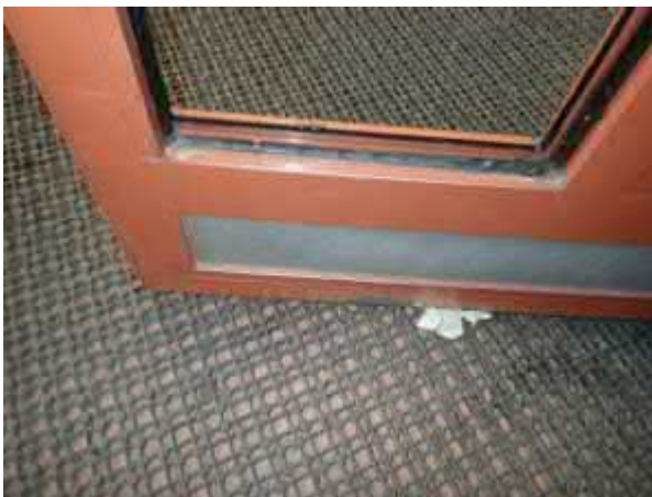
Kuvat 23 ja 24. Ulko-ovien malli. Ulko-ovilehtien välissä on rako, jonka takia ne eivät ole tiiviit ja energiatehokkaat. Ovien ulkoseinäpintoihin kiinnitetyissä peitelistoissa oli rakoja. Muutoin ulko-ovien toimivuudessa ei havaittu puutteita.
