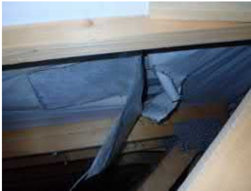
Kuvat 42 ja 43. Aluskate repsottaa monin paikoin. Johtoläpiviennit eivät ole tiiviitä.
