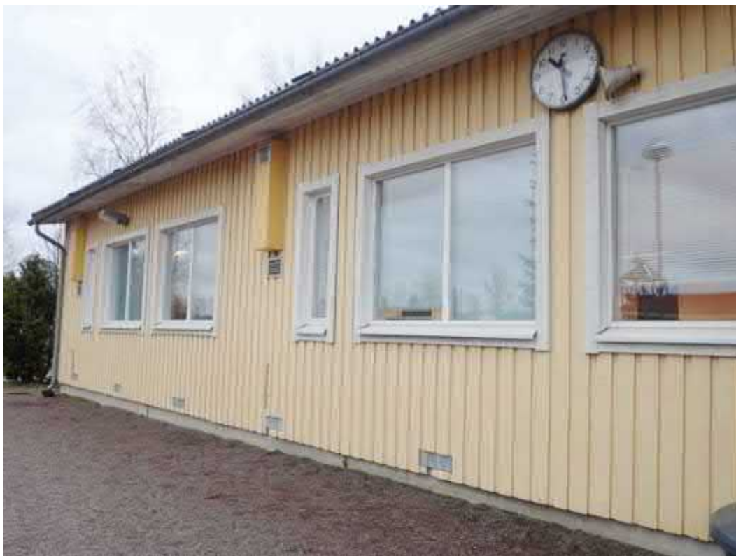
Kuva 18. Puinen julkisivulaudoitus on pääosin kunnossa
