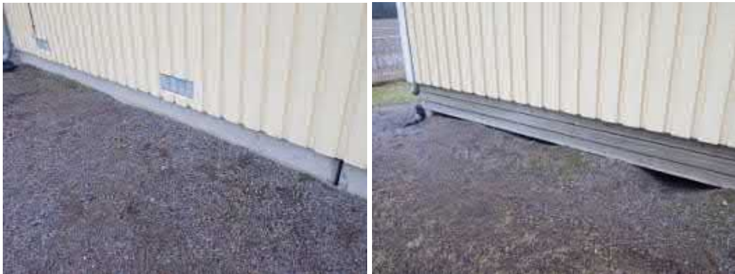
Kuvat 3 ja 4. Ryömintätila tuulettuu tuuletusaukkojen, avointen elementtisaumojen sekä päätyjen puupaneloinnin väleistä.
