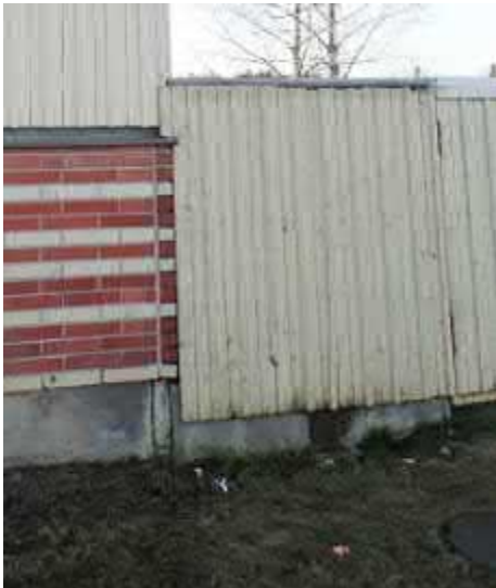
Kuvat 9, 10 ja 11. Tila 199. Ulkoseinällä havaittiin merkkejä kosteusvauriosta.
