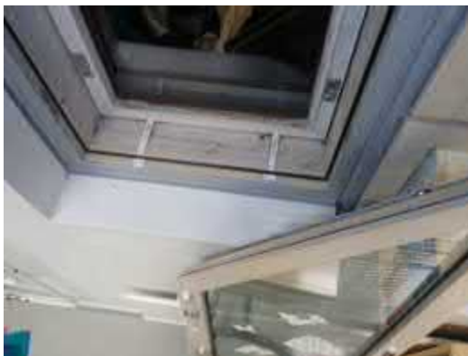
Kuvat 20 ja 21. Tyypillinen ikkunarakenne. Alhaalla keskellä olevaa tuuletusikkunaa lukuun ottamatta ikkunoissa ei ole saroja.
