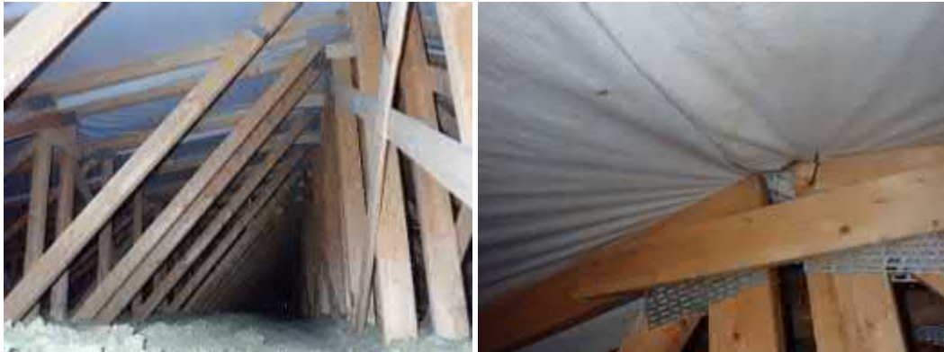
Kuvat 36 ja 37. Yläpohjatilassa kattotuolit ja aluskate ovat yleisesti hyväkuntoisia.
