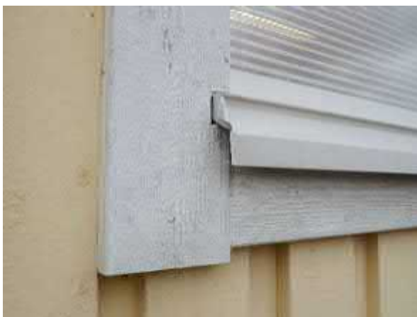
Kuva 27. Räystäspellitysten ylösnostot ovat vesitiiviit
