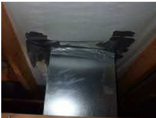
Kuvat 44 ja 45. Epätiivis läpivienti.
