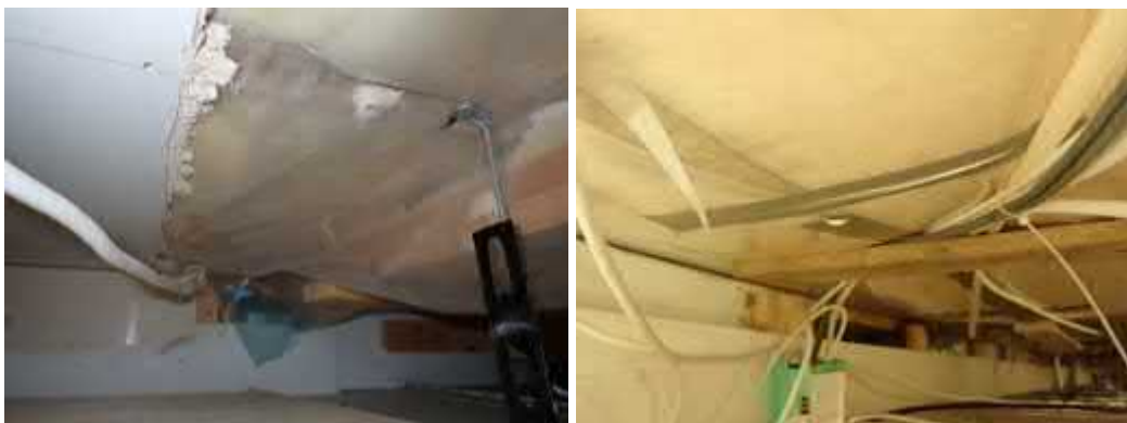
Kuvat 50 ja 51. Aukinaista höyrynsulkua.
