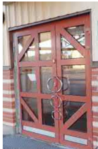
Kuvat 23 ja 24. Ulko-ovien malli. Ulko-ovilehtien välissä on rako, jonka takia ne eivät ole tiiviit ja energiatehokkaat. Ovien ulkoseinäpintoihin kiinnitetyissä peitelistoissa oli rakoja. Muutoin ulko-ovien toimivuudessa ei havaittu puutteita.
