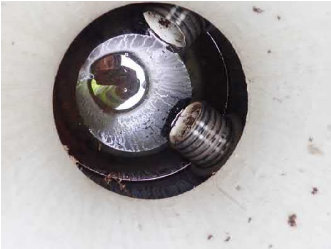
Kuva 55. Salaojissa on veden pinta putken alapinnan tasossa ja salaojat vaikuttavat toimivan suunnitellusti
