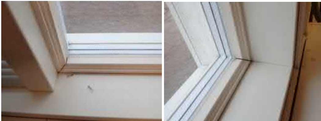
Kuvat 25 ja 26. Ikkunat ovat hyvässä kunnossa.
