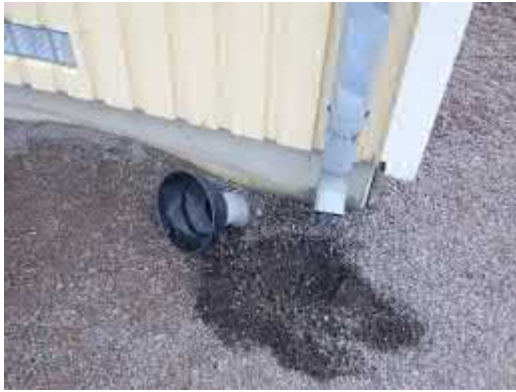
Kuvat 53 ja 54. Sadevesikourujen vedet ohjautuvat sokkelin viereen ja vedenkerääjät ovat pois paikoiltaan.
