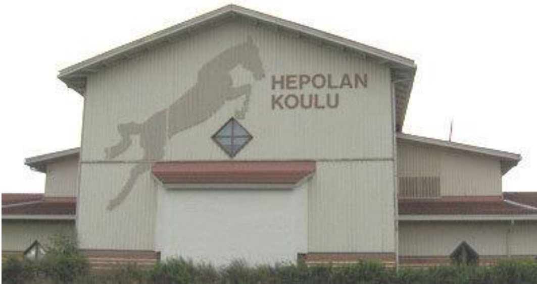
Hepolan koulun päärakennus valmistui 1991. Rakennus on aukinaisen V:n mallinen, kuvan pääty on keskikohdan taitteesta. (Lähde: Mäntsälä, Peda.net)
