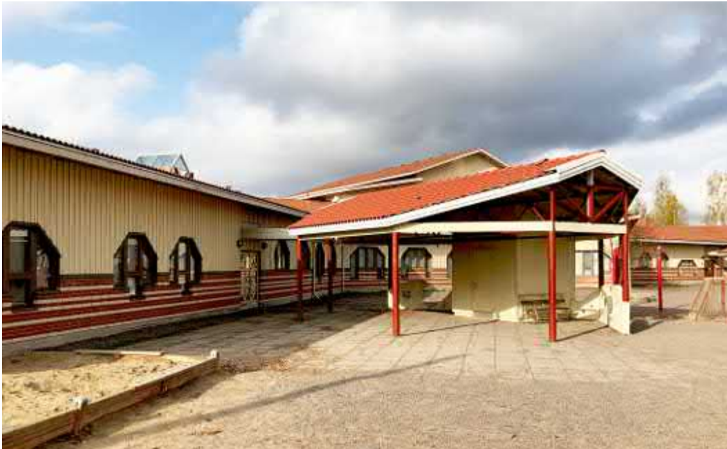
Hepolan koulun A-osan sisäänkäynti ja yksi kolmesta pihakatoksesta
