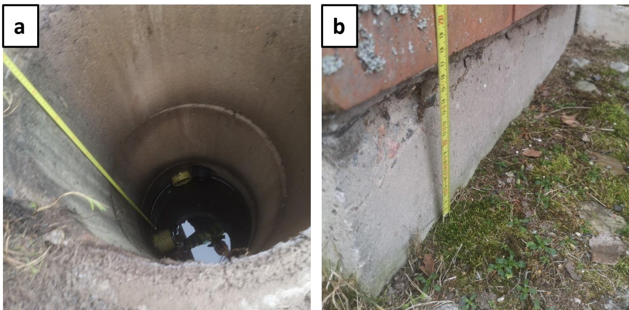
Kuvat 3a ja b. Salaojakaivon ja -putkien korkotason tarkasteluja.
