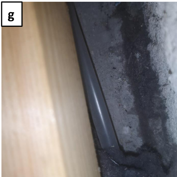
Kuva 12. Alapohjiin/lattiarakenteisiin tehtyjen avauksien havaintoja. Kuvissa a ja b näkyy rakennetyypin AP1 rakennekerrokset, kuvissa c ja d on tehty rakenneavaukset anturoiden juureen ja kuvat e...h on otettu liikuntasalin lattian rakenneavauksesta. Kuvassa g näkyy liikuntasalin lattian alapuolella olevaa pölykertymää.
