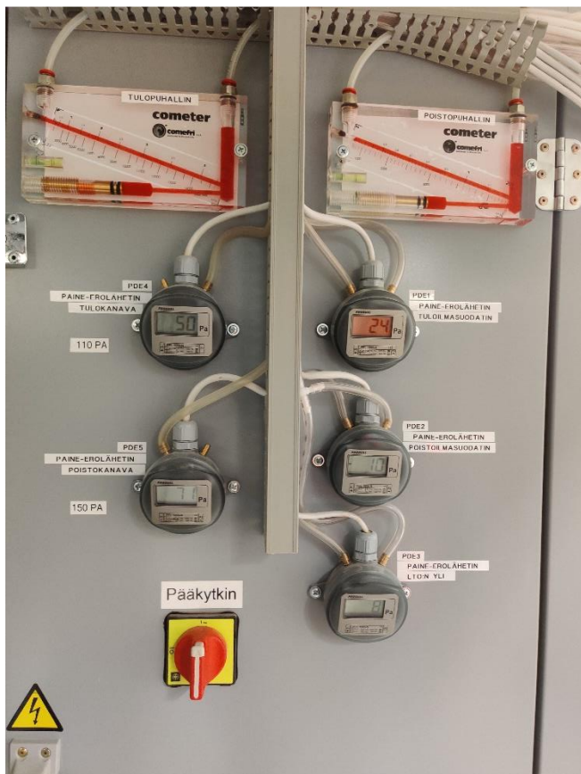
Kuva 41. TK5:n paine-erolähettimet
