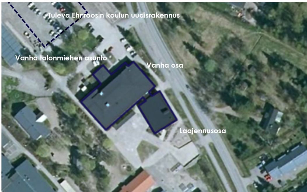
Ilmakuva Myllymäen koulusta. Luoteissivulla, rakennettavan Ehnroosin koulun suuntaan, vanha talonmiehen asunto sekä tulevan yhdyskäytävän liittymiskohta. Kaakossa koulun laajennusosa. (Taustakuvan lähde: Paikkatietoikkuna, ortokuva)
