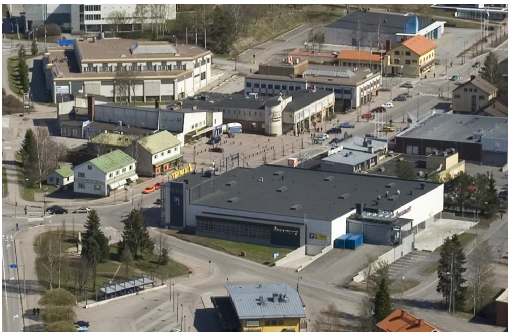
Kuva 10. Mäntsälän keskusta vuonna 2007. Marketti on rakennettu.
