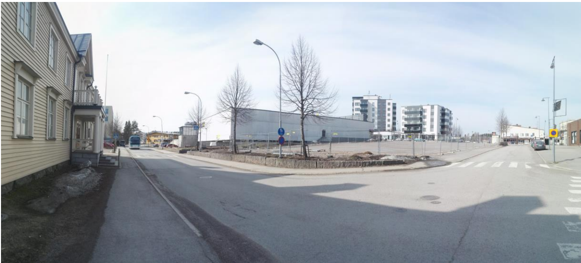
Kuva 3. Huvitie lounaaseen. Vasemmalla Seurojentalon parkkipaikka ja asuin kerrostalo. Oikealla marketin autopaikoitus ja kadun päässä oikealla BioRai.
