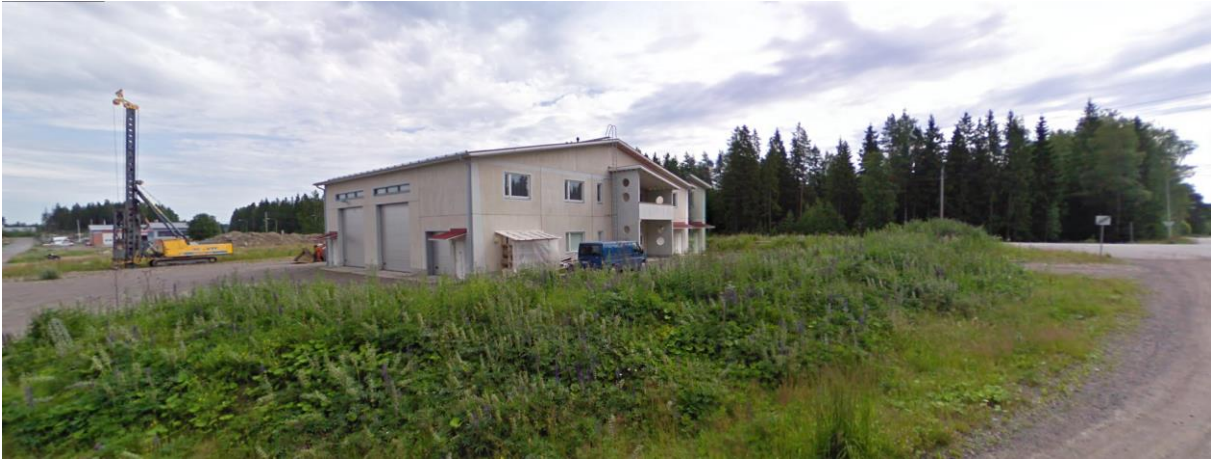
Kuva 2. Linnatien ja Mt140 risteyksessä oleva naapurikiinteistö.
