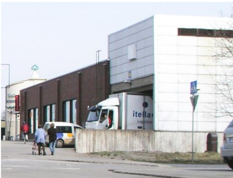
Kuva 14. Kapinakujan itäpuolella on liikerakennus, jossa toimii mm. posti.
