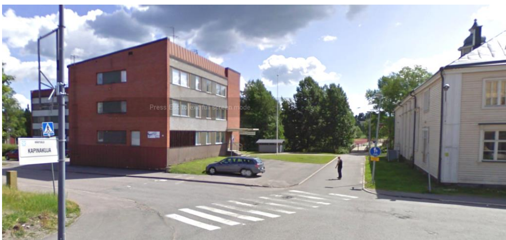
Kuva 15. Huvitien asuinkerrostalo. Kapinakuja päättyy Huvitien risteykseen. Markku Niinimäen raitti on kevyen liikenteen väylä urheilukentälle.
